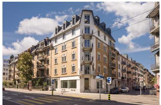
^ Durch das Aufstocken der städtischen Liegenschaft in Holzbauweise konnte zusätzlicher Wohnraum geschaffen werden.
