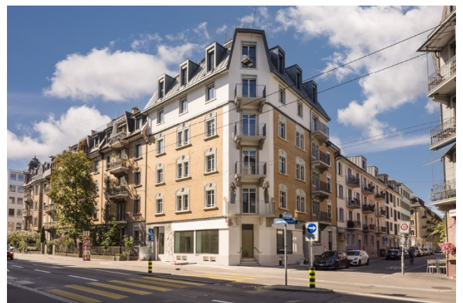
^ La surélévation en bois de l'immeuble a permis de créer un espace de vie supplémentaire.
