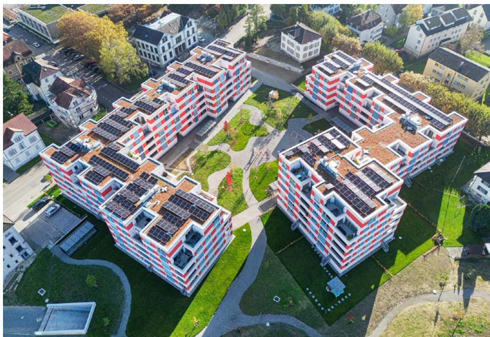
Des zones de rencontre dans les zones d'entrée, les pergolas ou, comme dans cet exemple à Romanshorn (TG), dans la cour intérieure commune créent des opportunités de contact social.
